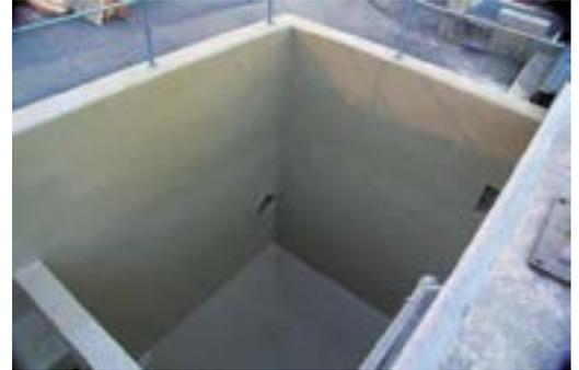
**Résine polyurée anticorrosion projetée à chaud**
