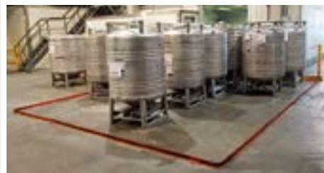
La barrière est composée d'une **tôle en acier perforé**, hermétiquement enveloppée dans du polyuréthane. Cette matière possède une très haute **résistance** aux produits chimiques et à l'**usure** et n'empêche pas la circulation des engins.
